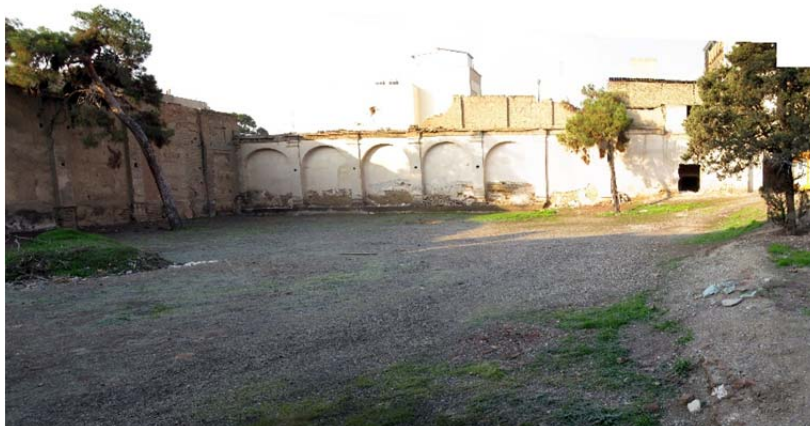
شکل ۱۱. نمایی از حیاط شماره ۳ موسوم به حیات «هنر» پیش از آغاز عملیات خوانا سازی
